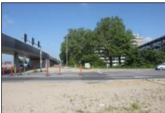
figuur 3.6. Foto van kruising Viaductweg, Meersenerweg.
