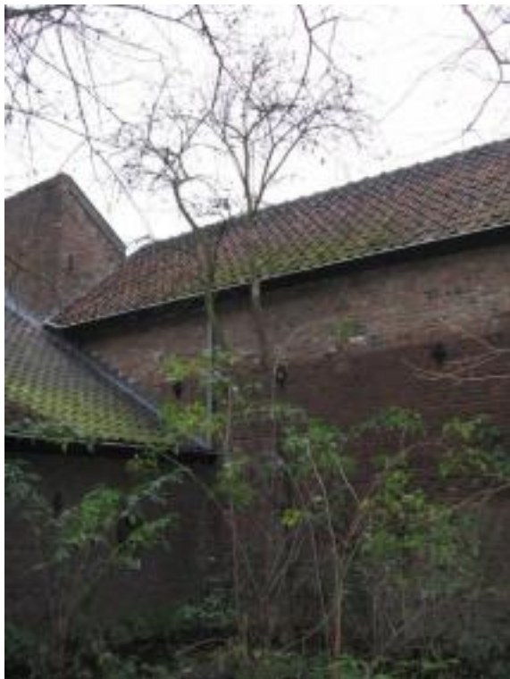
Foto 6; boom 3 tegen de achtergevel.
