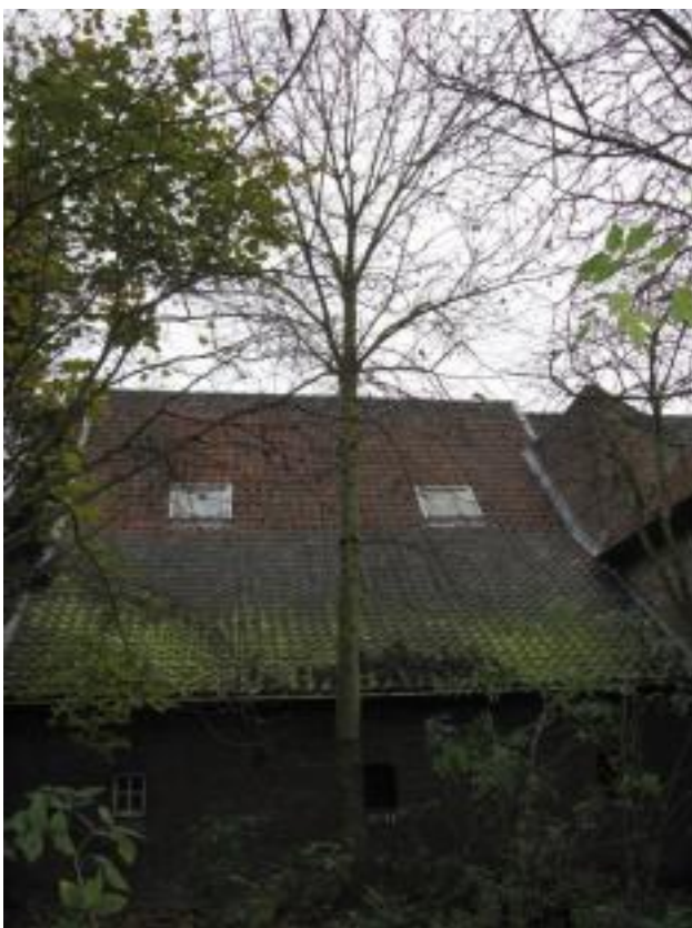
Foto 4; boom 2 tegen de gevel van de achterbouw
